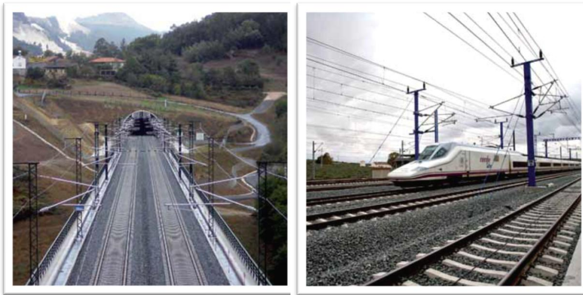
Figuras 3 y 4: Construcción de líneas ferroviarias de Alta Velocidad
