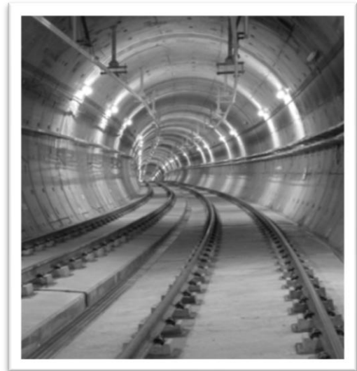
Figuras 9 y 10: Túneles
