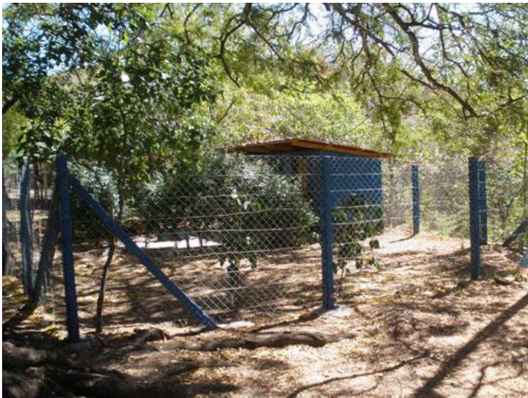
Cerco alrededor del pozo
