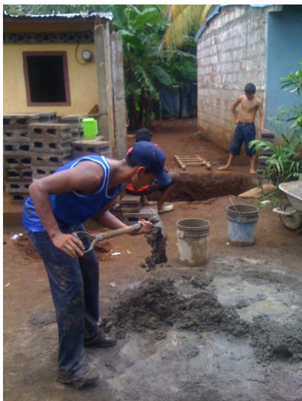
Construcción de Sistema Independiente de Saneamiento
