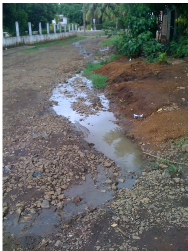
Aguas grises en la calle
