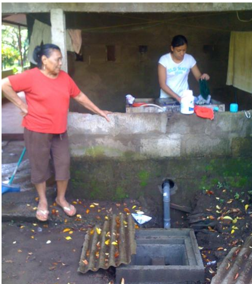
Conexión del agua gris a la fosa
