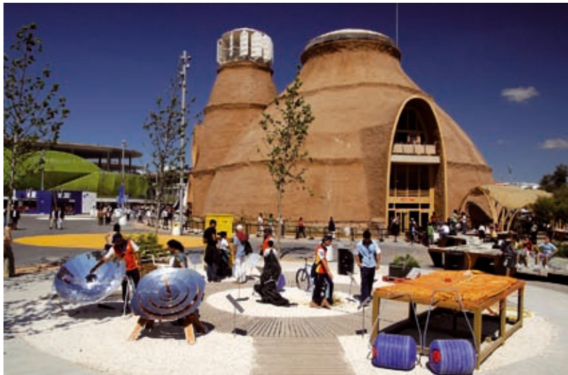
Edificio El Faro construido de paja, barro y madera certificada con criterios de eficiencia energética y sostenibilidad
