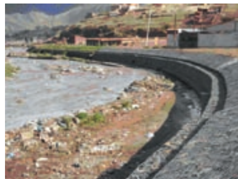
Construcción de defensas ribereñas en el río Huatanay (Perú)
