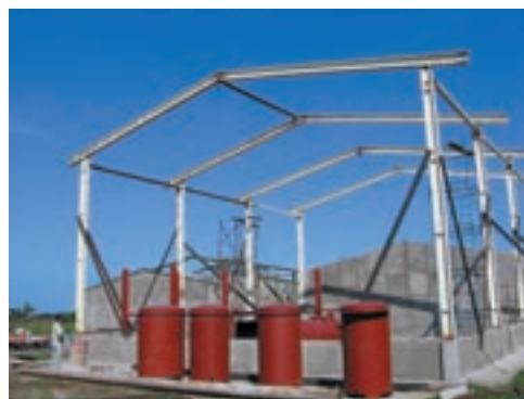
Construcción de la planta agroindustrial en Chinandega (Nicaragua)
