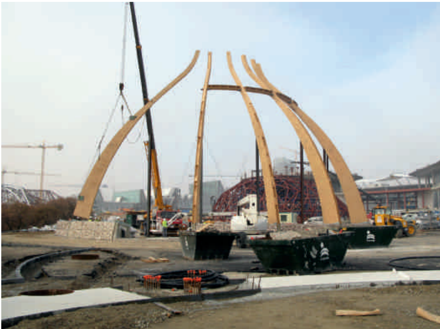
El Faro en construcción. Enero 2008
