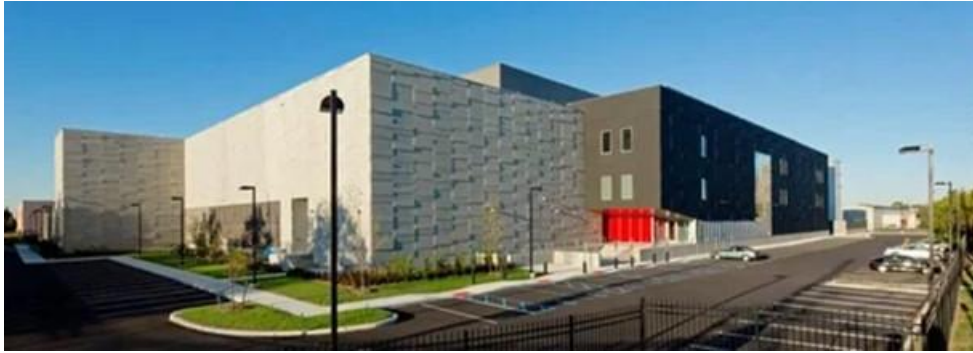
Figura 3. Centro de datos de colocación: Equinix
