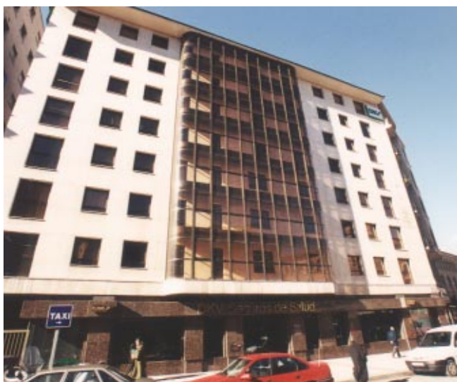
EDIFICIO DE DKV SEGUROS
