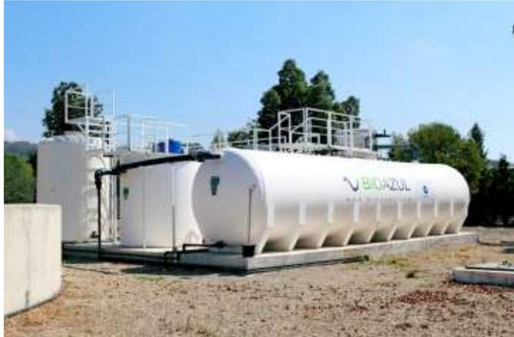
Figura 25. Planta de RichWater compuesta por un sistema combinado de tratamiento y reutilización de aguas residuales (Algarrobo, Málaga).
