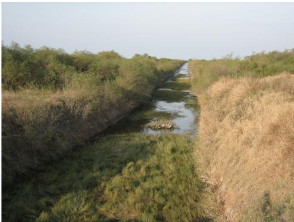
Canal construido en los Bajos Submeridionales
