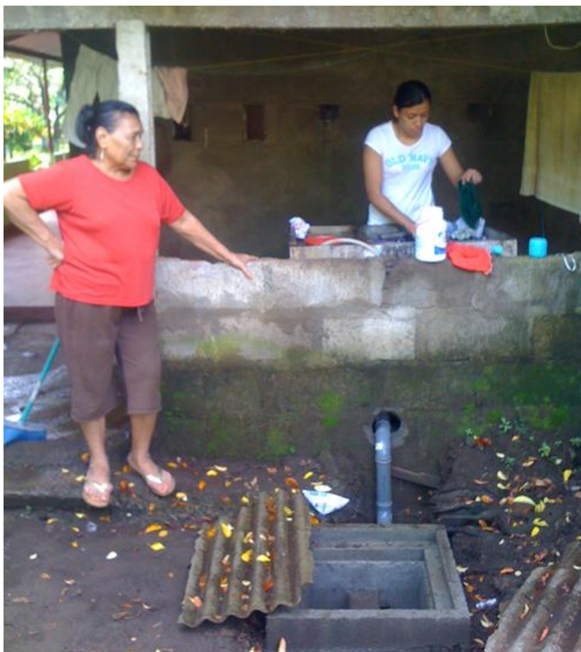
Conexión del agua gris a la fosa
