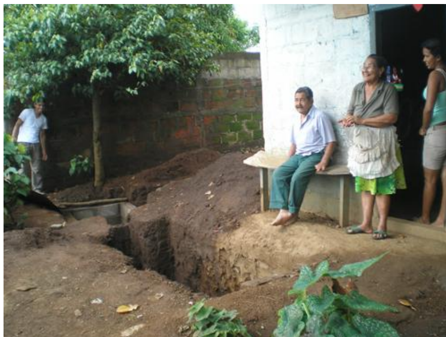
Obras en el patio
