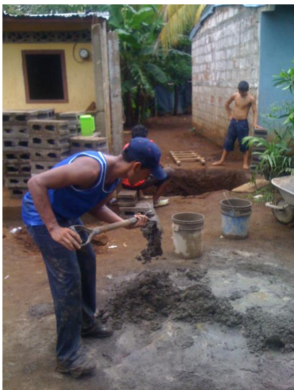
Construcción de Sistema Independiente de Saneamiento
