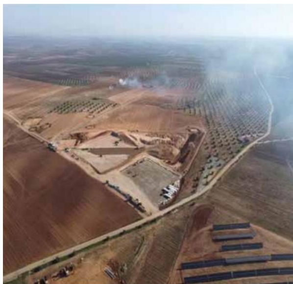
Imagen 10: Complejo fotovoltaico Extremadura I-II-III [8]
