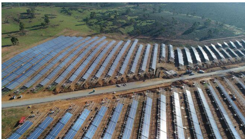
Imagen 5: Planta fotovoltaica de Andévalo (Huelva) [3]
