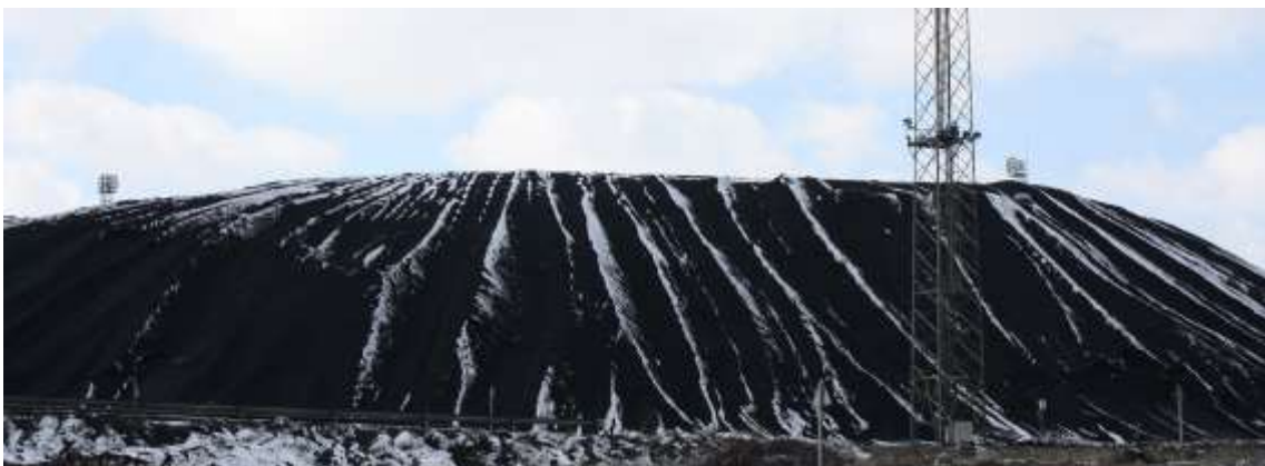
Almacenamiento de carbón en la Central Térmica Teruel en Andorra
